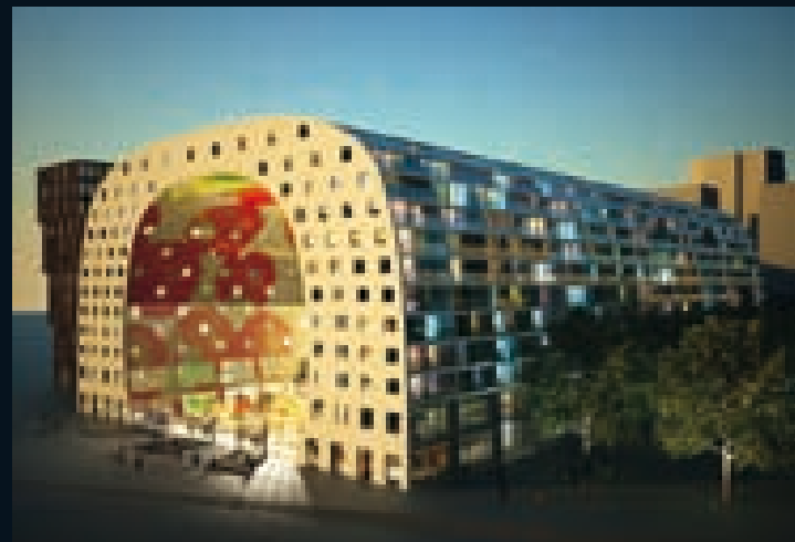
Markthal, Laurenskwartier Rotterdam (MVRDV)
