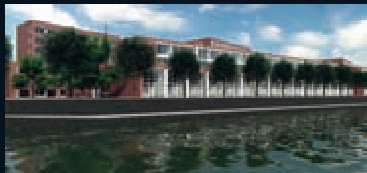
Steigereiland Noordbuurt Amsterdam (vmx Architects)
