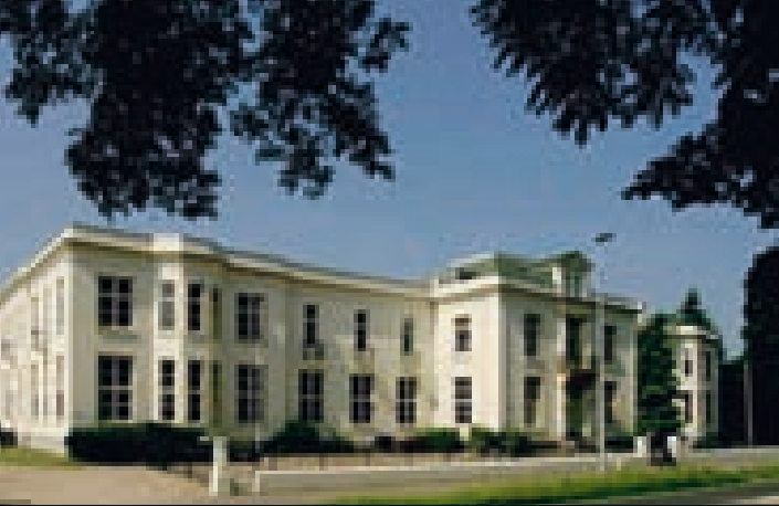
Rosorum, Arnhem (renovation: Van Ouwkerk Geesink Weusten)
